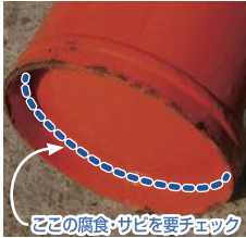
× 底部の腐食
